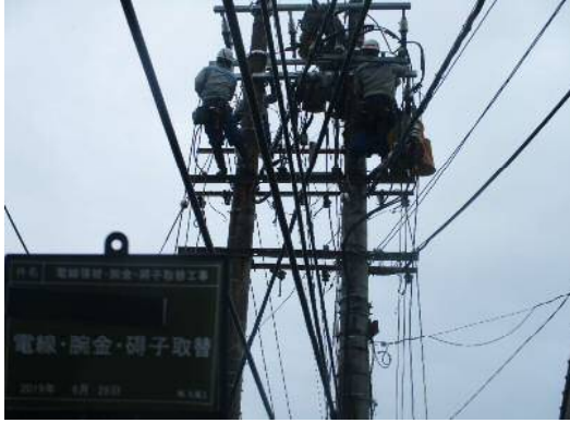
②山上及び高原付近高圧送電線更新(6月～7月)
