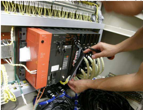
位置検出器の点検・部品交換
