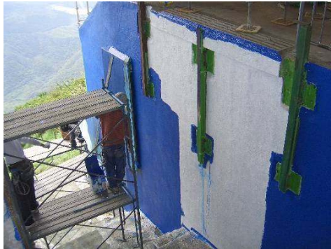
ホームピットの塗装
