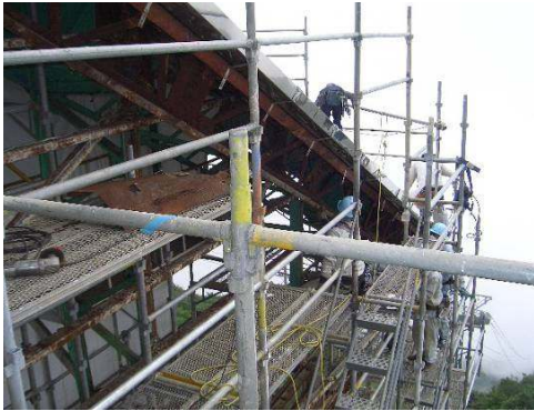
ホーム壁面改修
