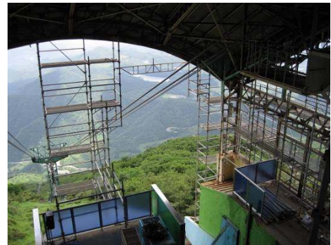
手摺、引戸の改修
