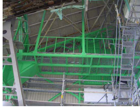
点検台の改修
