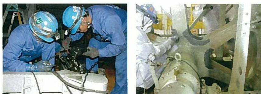
・高圧受電設備更新（気中開閉機及び遮断機等交換 第二期）（7月）
